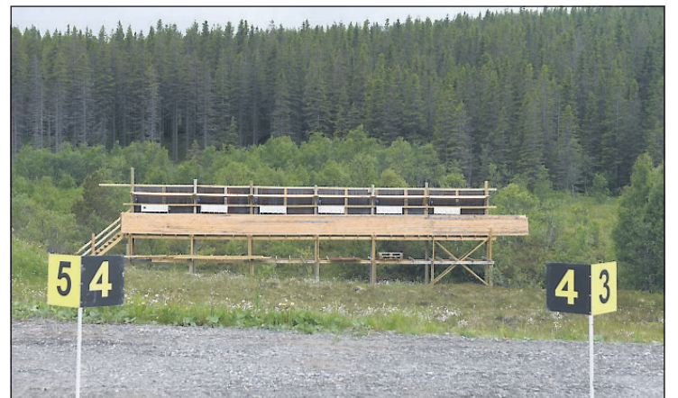
STANDPlass: Slik ser det nye anlegget ut fra standplass.
